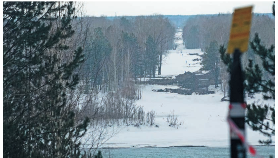
Ремонтируемый участок расположен в пойме реки Оби
