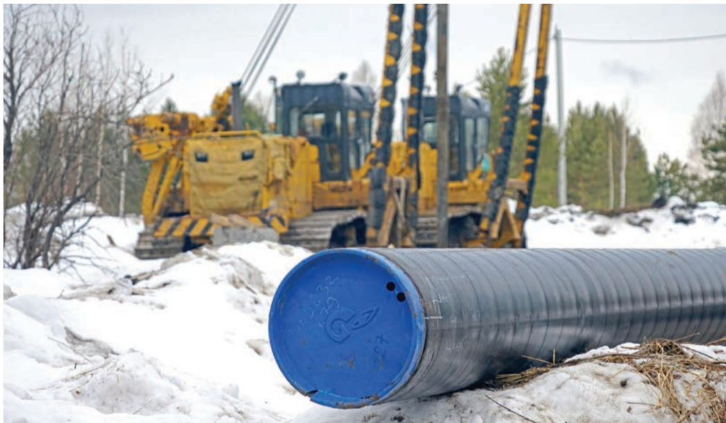
В ходе работ был заменен 5,5-километровый участок линейной части газопровода
